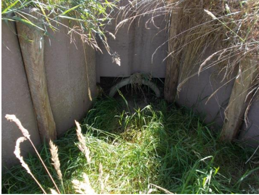
Foto 3 Faunatunnel niet in gebruik
