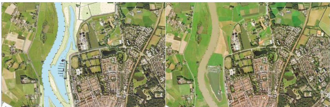
Figuur 2.2 In het kader van project 'Ruimte voor de Rivier' is Natura 2000-gebied Rijntakken t.h.v. het plangebied heringericht. Links de nieuwe situatie, rechts de oude situatie (bron: Combinatie IJsselfront).
