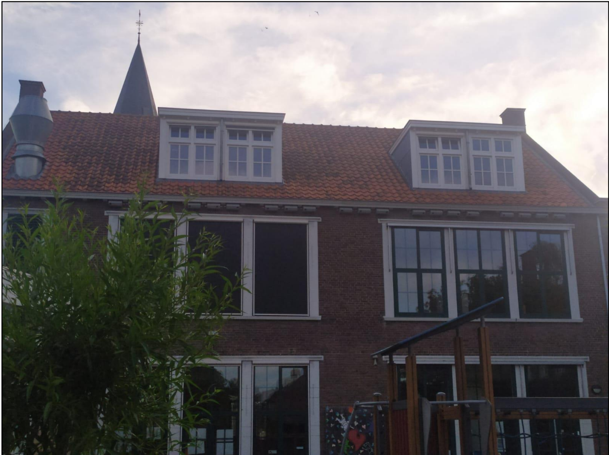
Figuur 4.1: gevel met bewoonde gierzwaluwkasten grenzend aan het plangebied.
