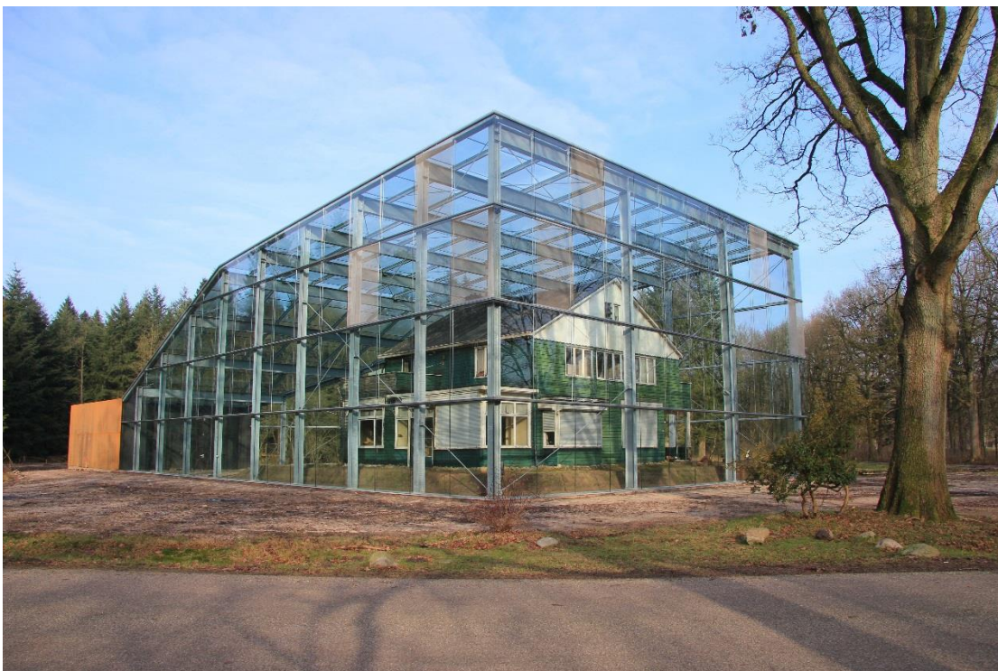
Woning kampcommandant na renovatie en realisatie overkapping
