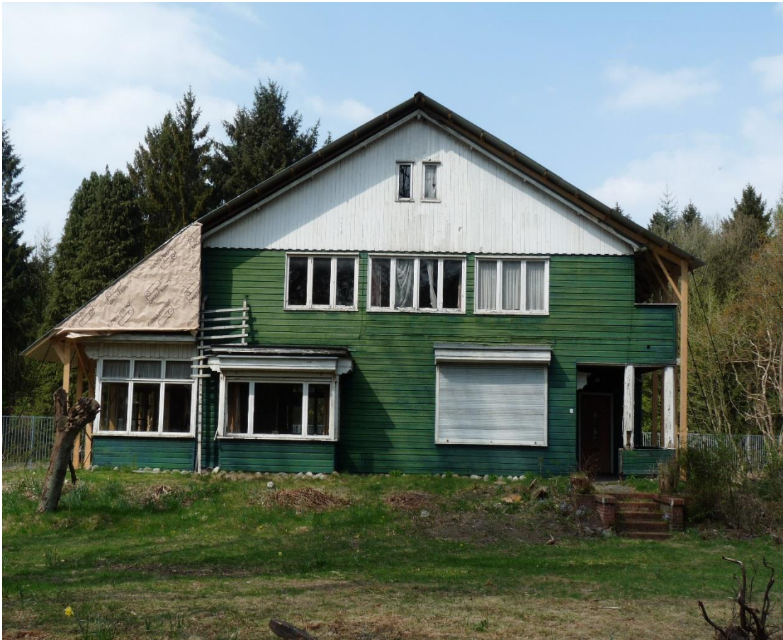
Woning kampcommandant voor renovatie (inclusief tijdelijke beschermingsmaatregelen)
