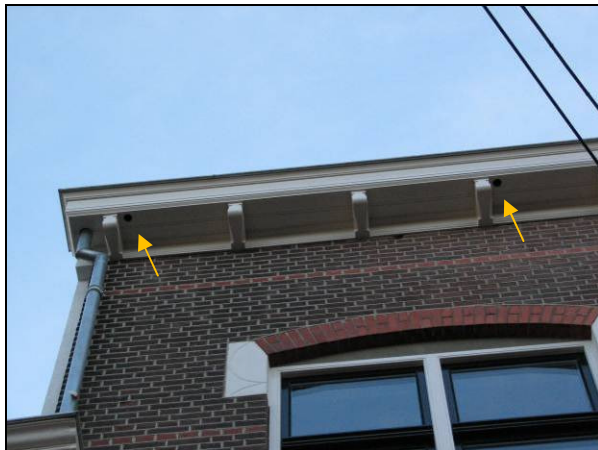
Figuur 3: Een voorbeeld van gecreeërde nestgelegenheid voor gierzwaluwen zonder pannen, stenen of kasten.
