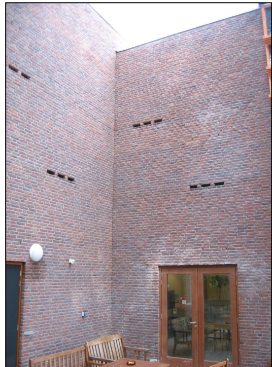
Fig. 3. Voorbeeld van geïntegreerde vleermuiskasten in het kantoor van het WNF in Zeist.
